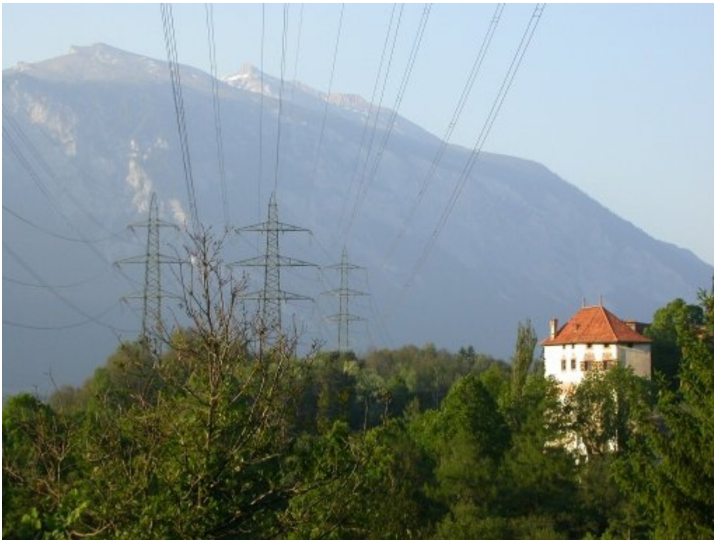
Bild 1: Freileitungen bei Rhäzüns
