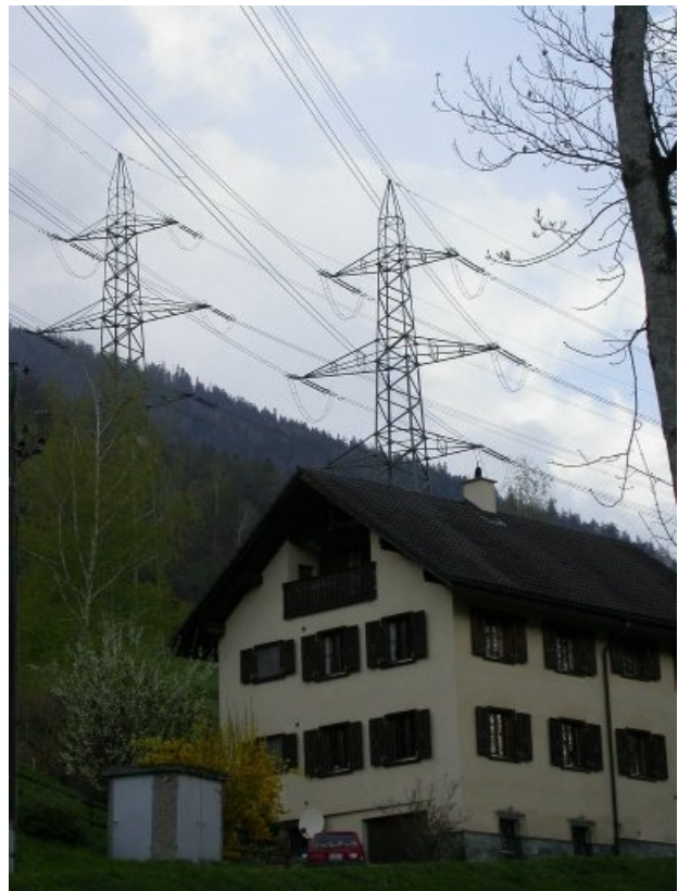
Bild 4: MFH in Untervaz mit EWZ- & NOK-Trassen
